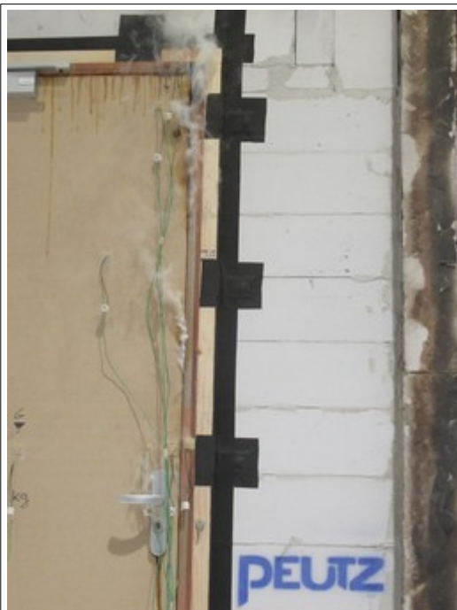
Foto 6: Beproeving na 16 minuten, rook uit slot en sluitzijde deur B
